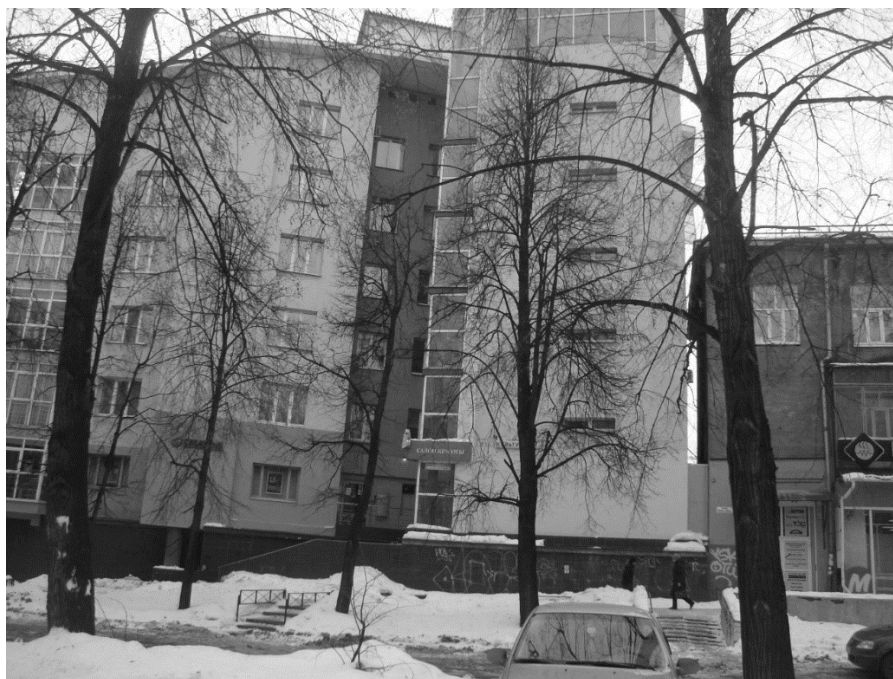
Рис.7. Высокая плотность застройки: расстояние между жилой вставкой и соседними зданиями 2,5 м
